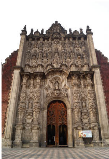
La portada del Sagrario Metropolitano de la Ciudad de México muestra varios juegos de columnas estípites dobles: donde termina una, comienza la otra.
