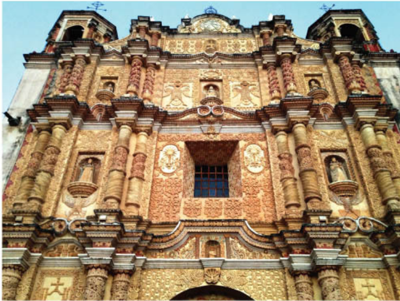
Detalle de la portada del templo de Santo Domingo, en San Cristóbal de las Casas, Chiapas. Son visibles los nichos laterales que dan acomodo a las imágenes de distintos santos, junto con el nicho central —arriba de la ventana del coro— en el que se ubica la imagen de Santo Domingo de Guzmán.
