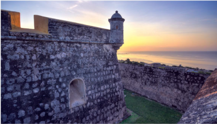
Las muestras más evidentes del pasado novohispano podemos encontrarlas en las construcciones que dejaron los españoles a su paso. Baluarte de San José el Alto, Campeche, construcción del siglo XVIII.
